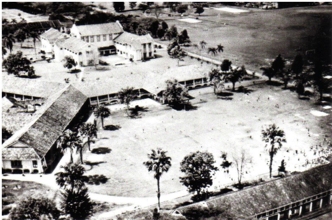
Gambar 2: Pemandangan dari atas, bangunan utama SITC pada tahun 1920-an (Sumber: Arkib Negara Malaysia)
